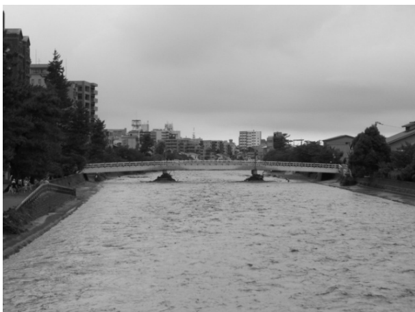
図1 浅野川の梅の橋付近 2008年7月28日小松哲氏撮影 (氾濫より1時間半後の様子。数分で水位が上がり氾濫)
